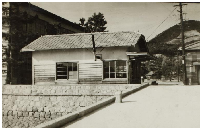
岸壁部分に設置された守衛所
