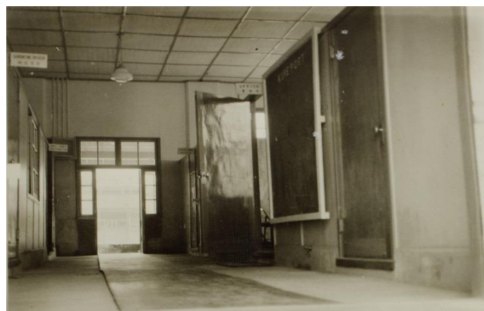
呉分室内部の様子
