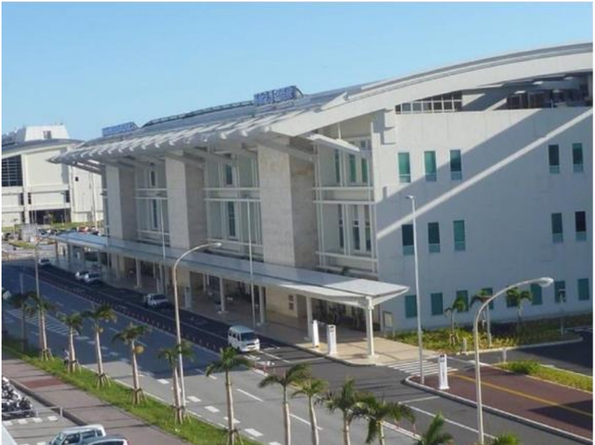
那覇空港国際線ターミナル
