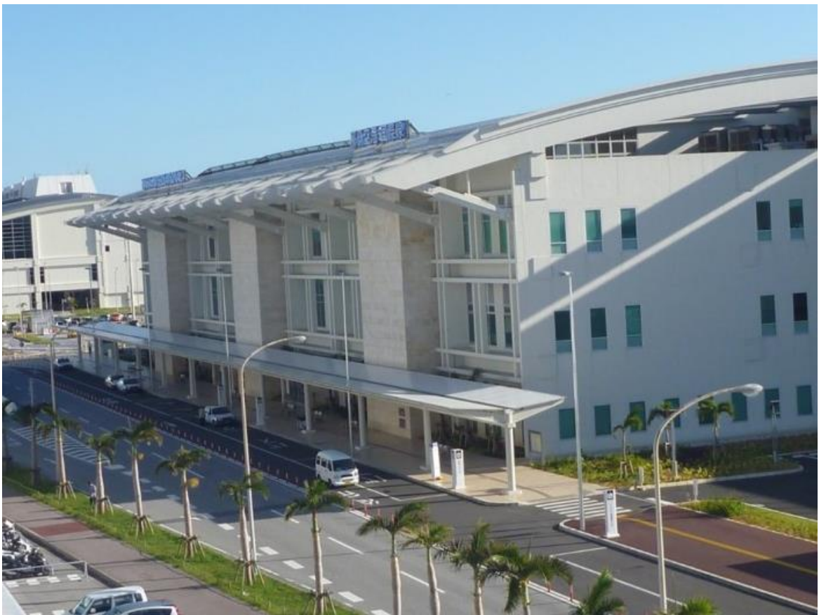
那覇空港国際線ターミナル
