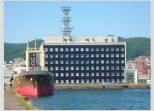
小樽地方合同庁舎
